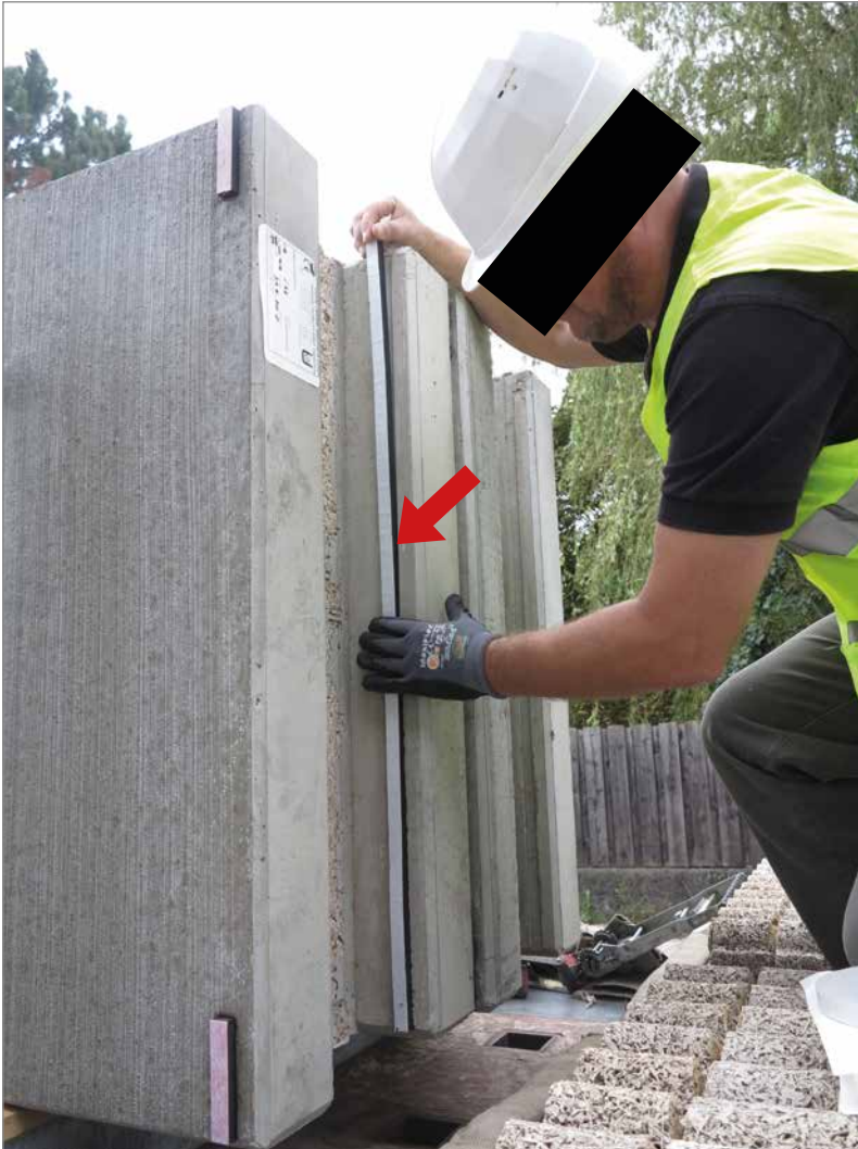
Einpressen über volle Höhe in ausgesparter Nut
