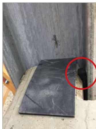
Panel mit Dichtband eins. volle Höhe, 2. Seite 10 cm Streifen zur Lagesicherung
