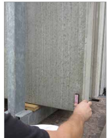
Einpressen der Lagesicherung
