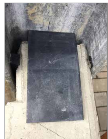
Panel mit Dichtband beids. volle Höhe
