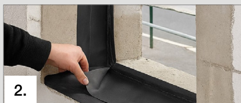
2. EPDM-Folie (zweite Dichtebene) anbringen
