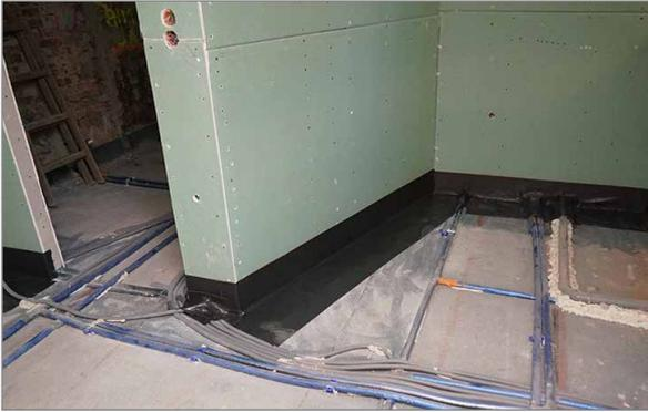
Der WETBelt® bietet einen zuverlässigen Schutz als Feuchtebarriere von feuchte sensiblen Baustoffen (Gipskartonwände, Holzfaserverbaustoffen, Holz, Kork usw.) gegenüber, nass eingebrachten Materialien wie Ausgleichsschüttungen, Beton und Estrichen während der Trockenphase und verhindert damit den mikrobiellen Bewuchs durch Schimmelpilze von Wandflächen während der Bauphase von Immobilien.
